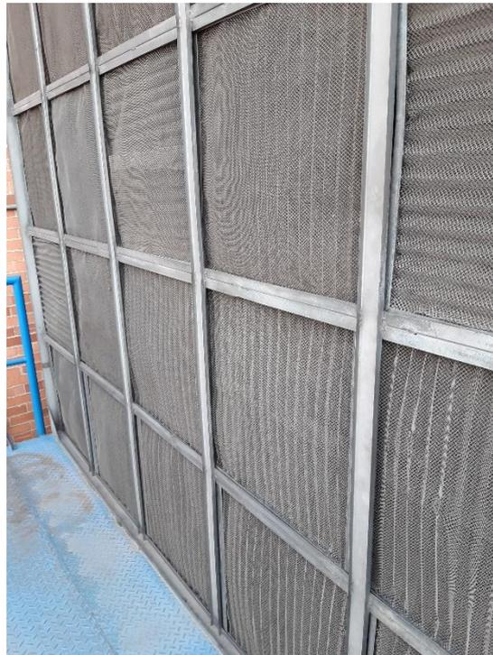
**NOTA: Se recomienda cambiar estos filtros por filtros AFP-50 MINI y AFP-70 MINI similar a los instalados en la unidad 2 por que estos no garantizan la calidad del aire en el sistema**
